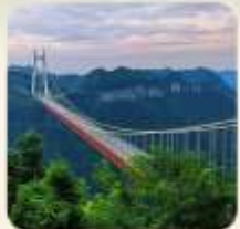
สะพานอ้ายจ้าย
